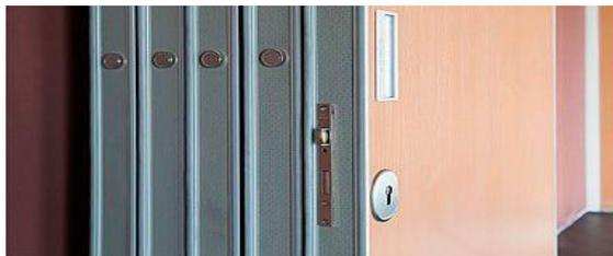
Крайняя панель выполняет функцию двери и фиксируется в закрытом положении защелкой и замком
